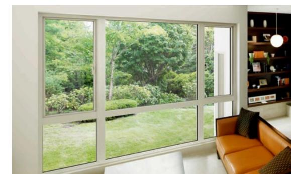
アルミの良さと樹脂の良さを融合した「ハイブリッド窓」を採用し、断熱性を高めることで空調
