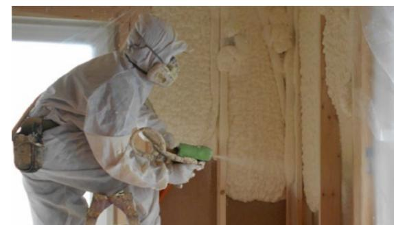
PRIMEでは、水で発泡する硬質ウレタンフォームを使用した「吹付け断熱」を現場施工して
